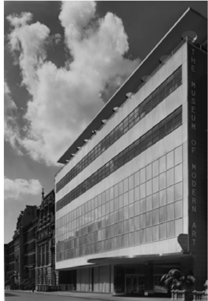
New York, Museum Of Modern Art, 1939, architectes : Philip L. Goodwin et Edward Durell Stone
